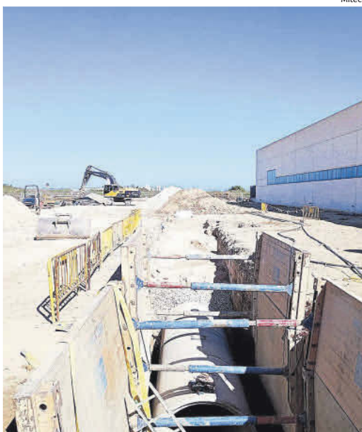
Obras en el colector de la EDAR de San Pedro del Pinatar.
